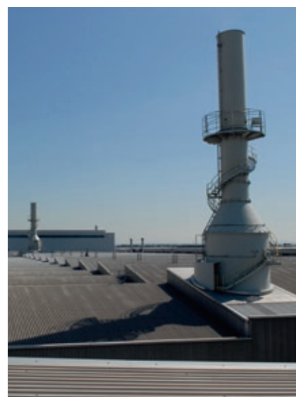
Abluftwäscher Kaltwalzwerk
